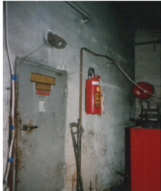
Nicht im, sondern vor dem Heizraum müsste die erste Löschhilfe angebracht sein.
