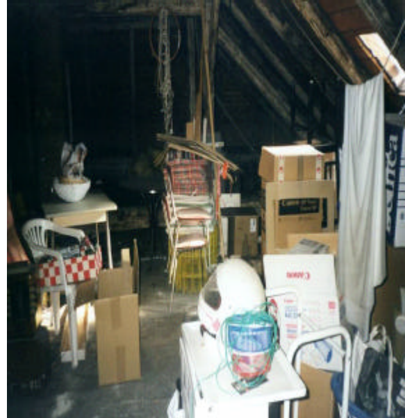
Gerümpel und brennbares Material lagert unsachgemäß am Dachboden
