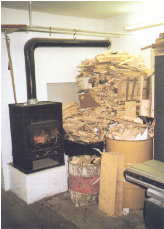
Unerlaubte und gefährliche Lagerung von Brennstoffen
