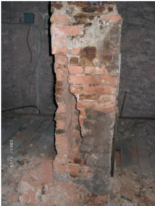
Sehr baufälliger sanierungsbedürftiger Schornstein
