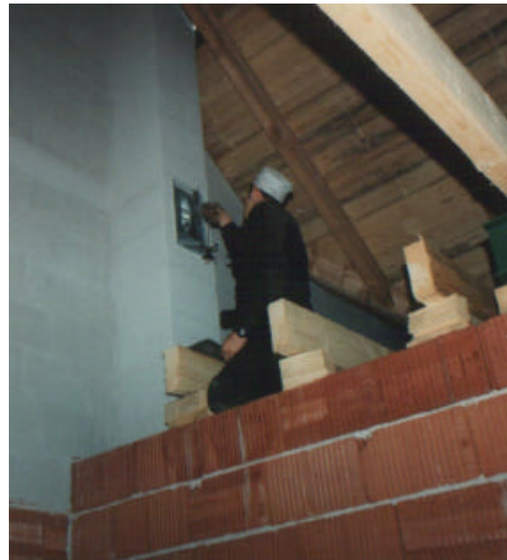
Der Schornsteinfeger bei der Erstüberprüfung nach Fertigstellung des Rohbaues
