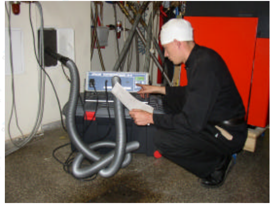
Ermittlung der Leckrate eines mehrschaligen Schornsteines
