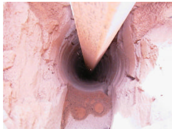
Vergrößerung des vorhandenen Schornsteinquerschnittes mittels Fräsmethode
