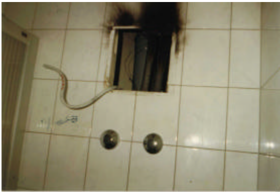
Nicht funktionsfähige Lüftungsanlage
