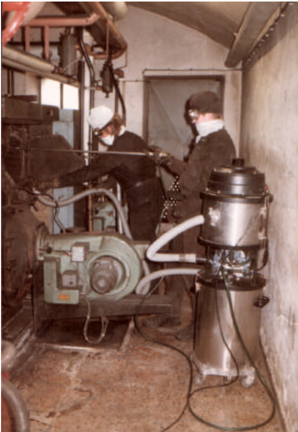
Chemisch mechanische Kesselreinigung
