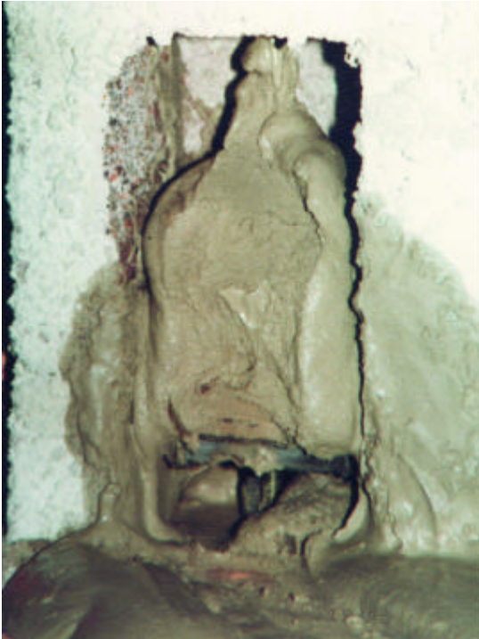
Innenabdichtung mittels Spezialmörtel und Gummipplatten
