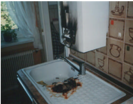
Verschmutzter Wärmetauscher verursachte Ruß- und Abgasaustritt in Gefahr drohender Menge
