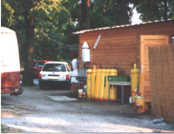
Im Zuge der äußeren Beschau festgestellte unzulässige Flüssiggaslagerungen
